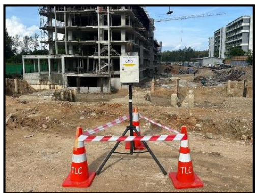
รูปที่ 3.4.3-2 การตรวจวัดคุณภาพเสียงรบกวน บริเวณพื้นที่โครงการ (ระยะก่อสร้าง)
